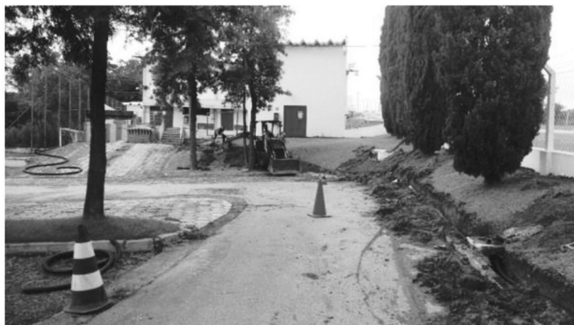
Figura 2 – Obra infraestrutura de fibra óptica
